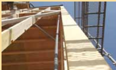
竜巻対策＝直径16mmのボルトを 基礎から軒桁まで通しています。
